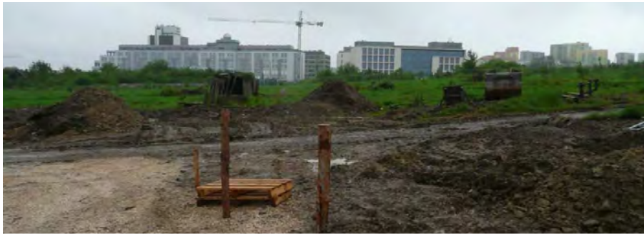
Teren przygotowany pod budowę kampusu B, w tle kampus A. Wybrane materiały z etapu przedrealizacyjnego kampusu B - stan z 2008r.
