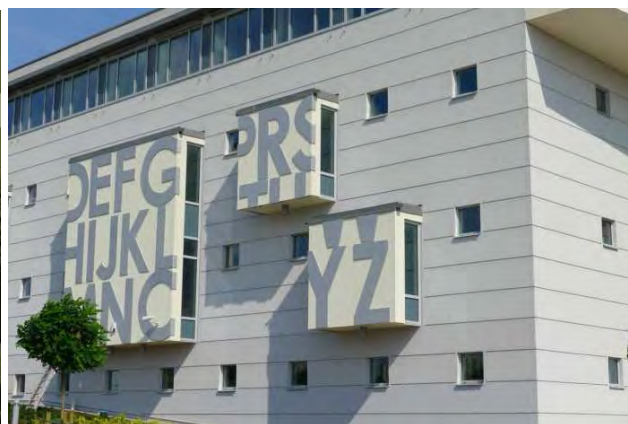
Fragment elewacji zachodniej. Wybrane elementy
