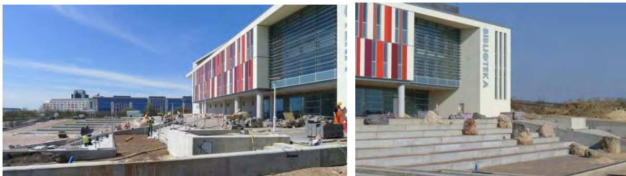
Budowa forum, w tle widoczna część A kampusu
