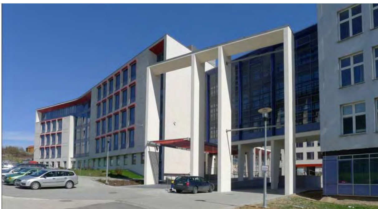
Portal od strony zachodniej, przejazd pod budynkiem. Wybrane materiały z drugiego etapu realizacji kampusu A. PPIP 2010-2012 r. Fot. własne.
