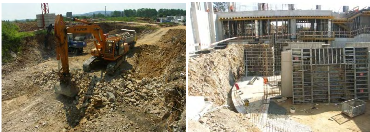
Prace na budowie w trudnych warunkach geologicznych. Głębokie fundamentowanie pod audytorium głównym - wentylatornia. Wybrane materiały z pierwszego etapu realizacji kampusu A. PPIp 2006 – 2008 r. Fot. własne.
