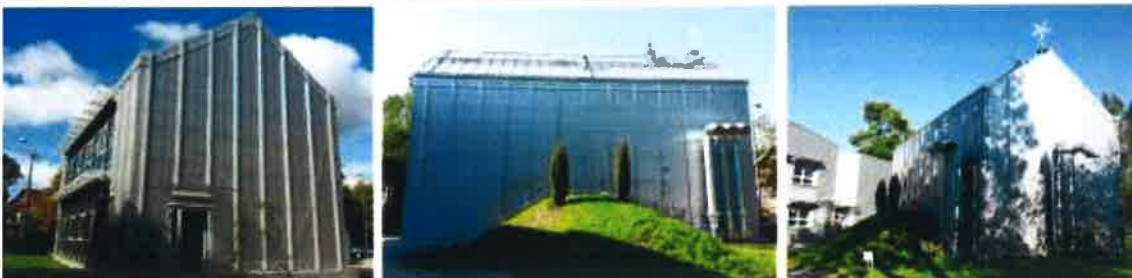
Il. 3. Budynek LAEiOE WA PB, elewacja południowa, na dole: elewacje: wschodnia z wejściem, północna i zachodnia, fot. autor
